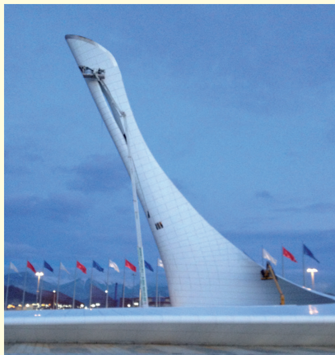
Bild 3. Nahezu fertiggestellte Struktur der olympischen Fackel im Dezember 2013, Durchführung der Schwingungsmessungen vor Ort
