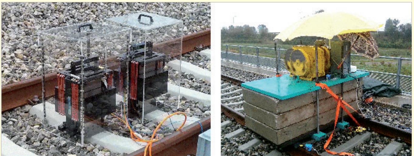
Bild 11. Eisenbahnbrücke G5 – linkes Bild: zwei Long Stroke Shaker in Gleisachse in Brückenmitte, rechtes Bild: mechanischer Unwuchterregern mit Zusatzmassen (Betonplatten)
