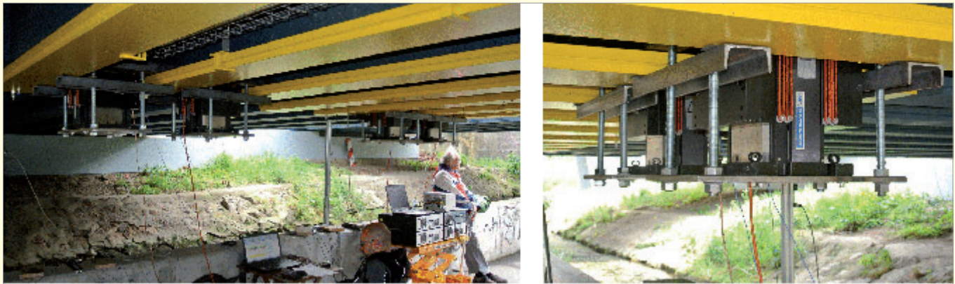
Bild 4. Krafterregte Schwingungsanregung mit Long Stroke Shakern bei der Mödlingbachbrücke Gleis 2
