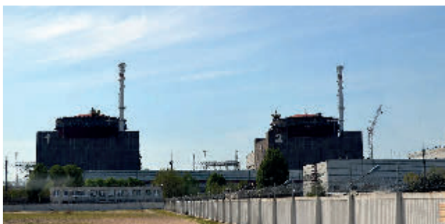
Blöcke 1 und 2 des Kernkraftwerk Saporischschja welches im Rahmen der Fallstudie betrachtet wird. Foto: Denamax, Wikimedia, CC BY-SA 4.0 [5]
