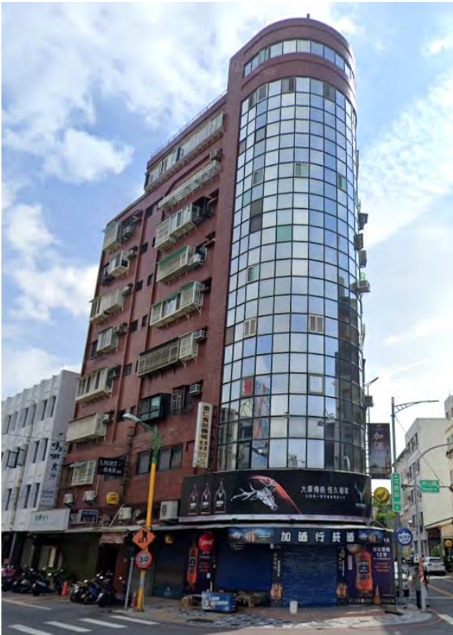
a) Vor dem Erdbeben (Ansicht vorn)
